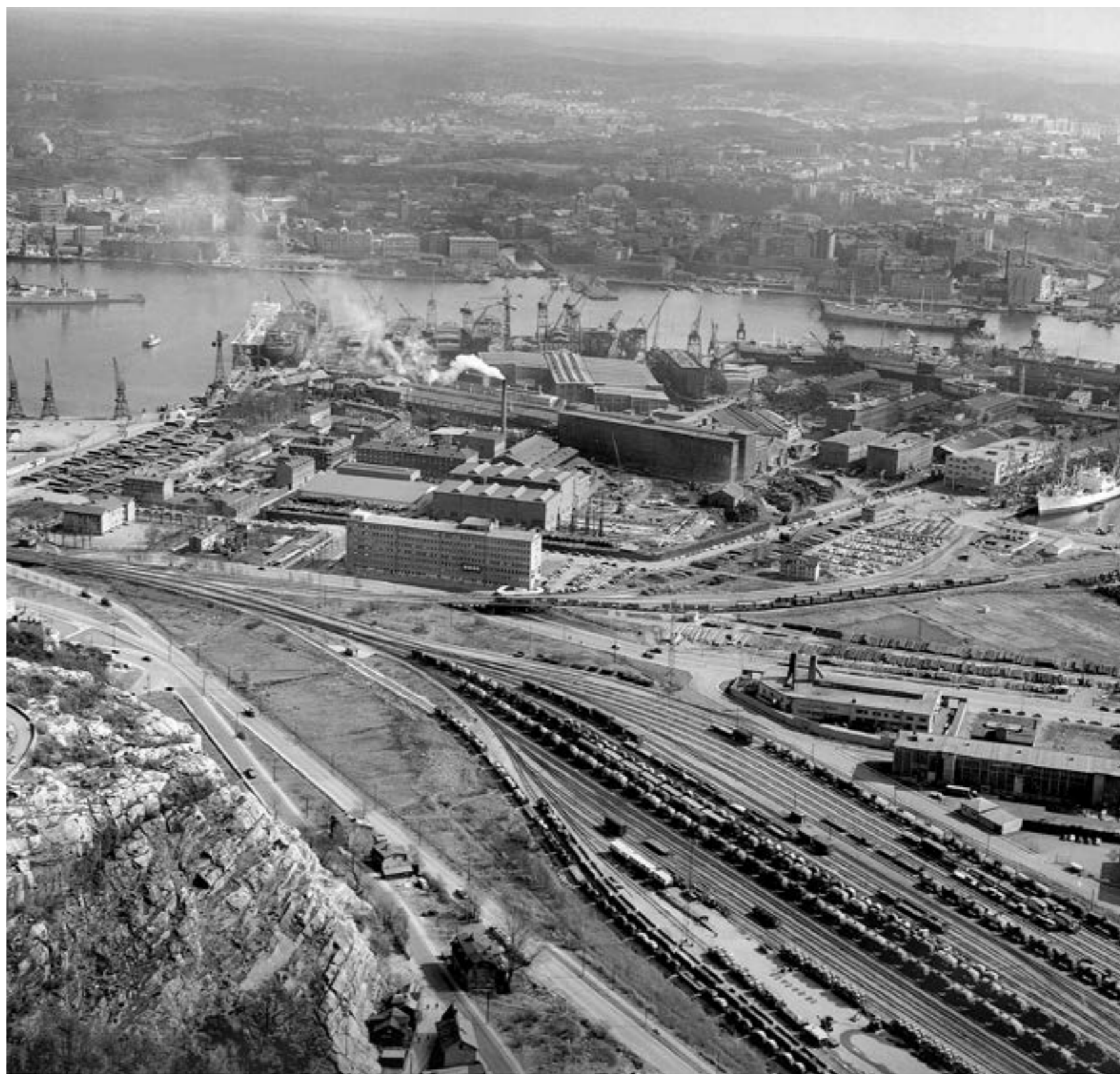
Vy från Ramberget söderut 1958. Kvarteret Propellerns Galvaniseringsfabrik, och andra verksamhetsbyggnader nere till höger, i direkt kontakt med Hamnbanan. GSM arkiv
