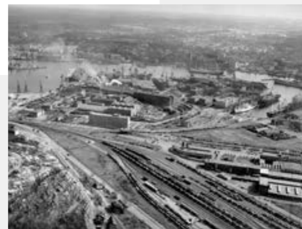
1958 Kvarteret Propellerns Galvaniseringsfabrik, och andra verksamhetsbyggnader i direkt kontakt med Hamnbanan. GSM arkiv
